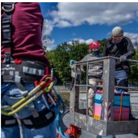
• Ule trzeba było podnieść na wysokość dachu
