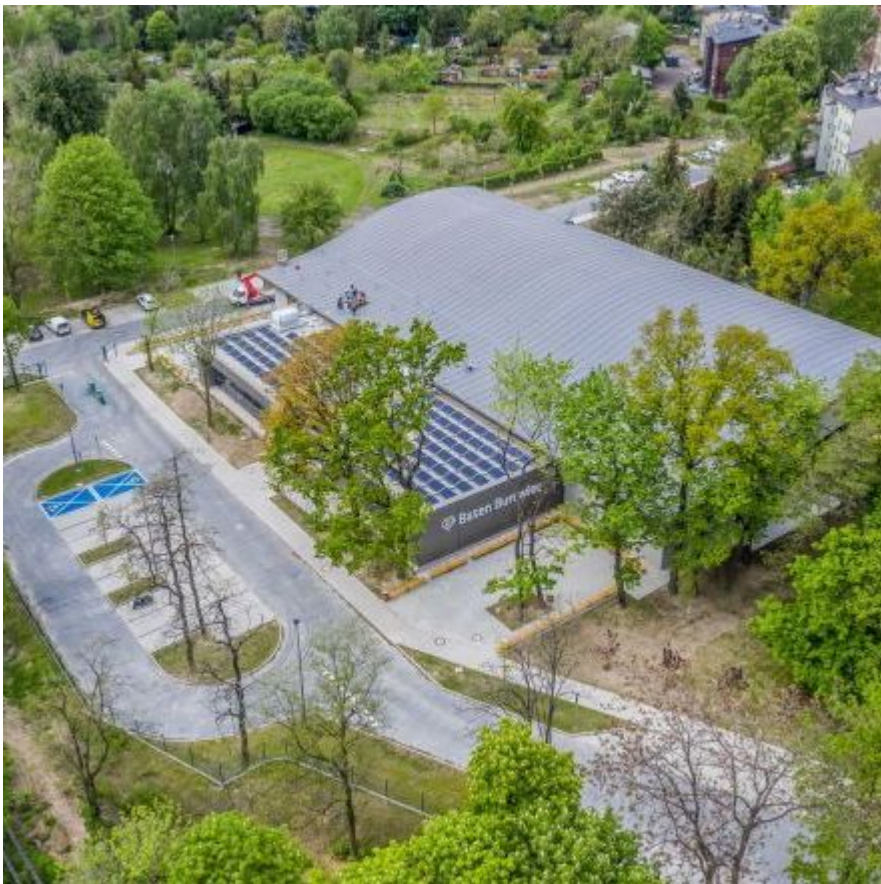
UI na dachu Basenu Burowiec
