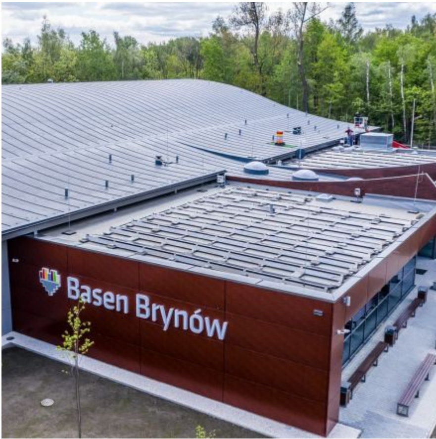
Ul na dachu Basenu Brynów
