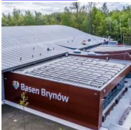
• Ul na dachu Basenu Brynów
