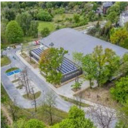
• Ul na dachu Basenu Burowiec
